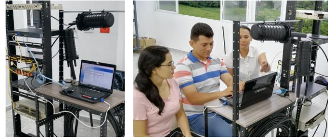
Fig. 4 Conexión y configuración por cable de consola.
