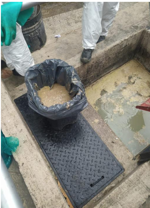
Fig. 1 Actividades de limpieza de trampa de grasas, aguas de casino.
